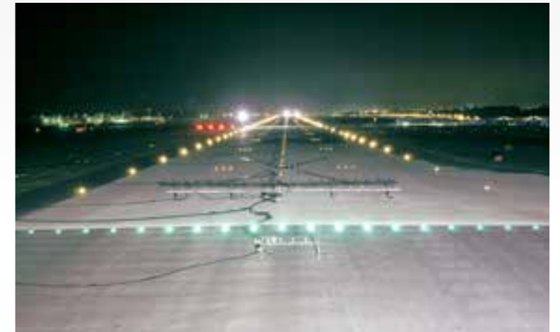
航空灯火設置工事
