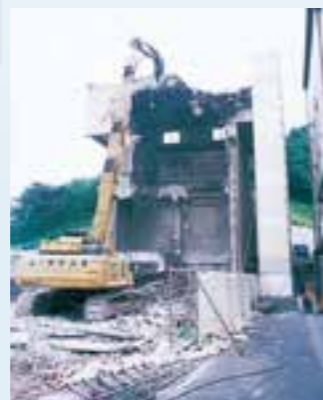
焼却炉解体工事
