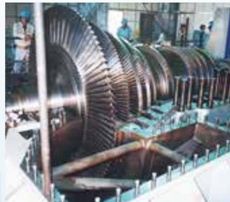
蒸気タービン据付け工事
