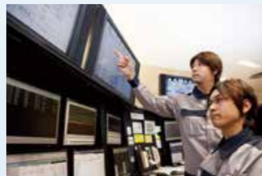
石油精製・石油化学プラント&ユーティリティ設備プロセスコンピュータ、計装システム更新および計器室統合工事
