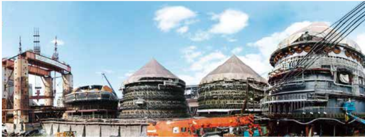
大型高炉大ブロックリング工法改修工事
