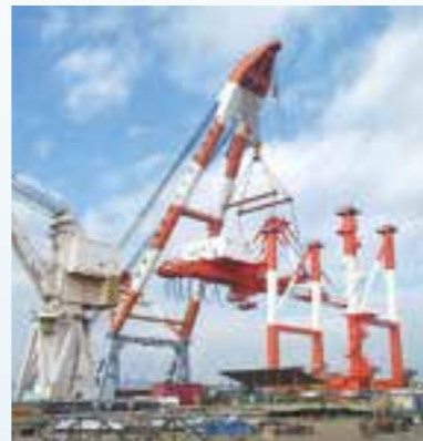
コンテナクレーン設置工事
