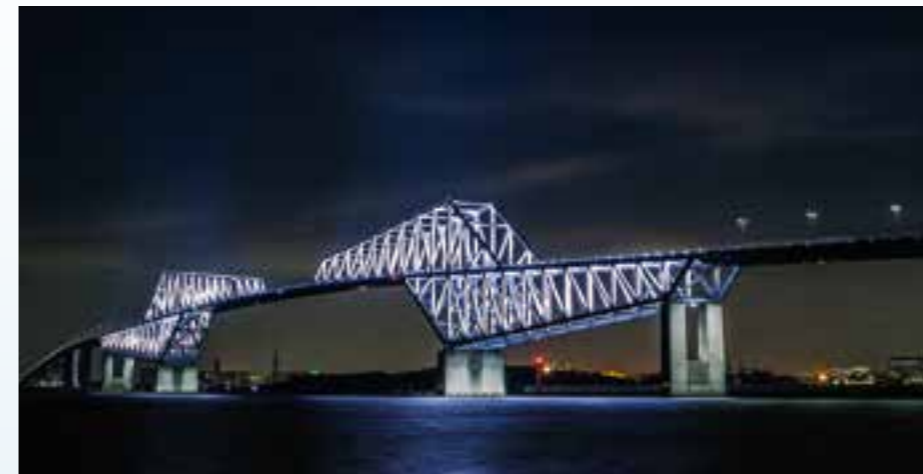
東京ゲートブリッジ照明工事
