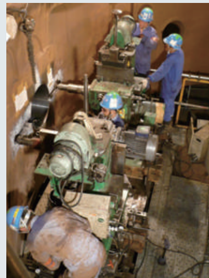
炉体更新工事
