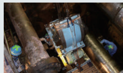
半割れ機械設置
