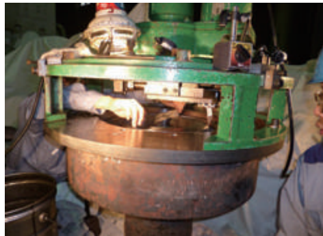
フランジV溝修正
