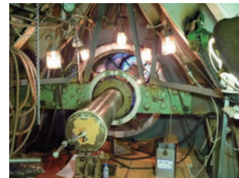
船尾管内径修正
