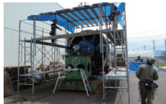
タワーフランジφ3000空き地での加工
