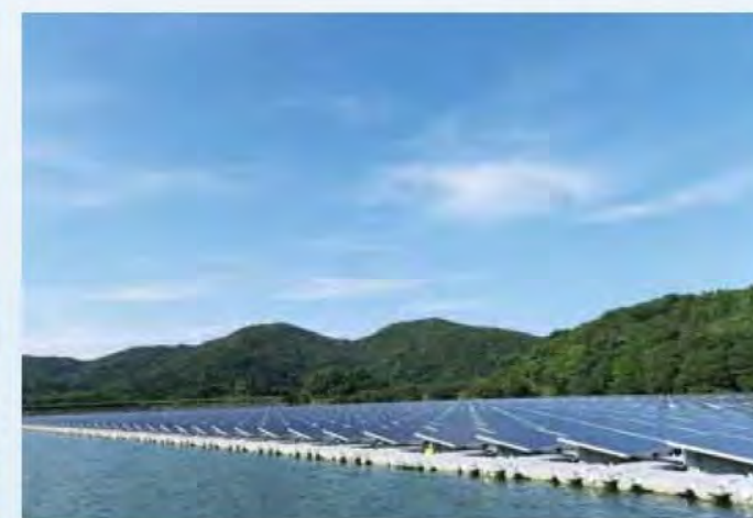
水面設置型(フロート型)太陽光発電システム
