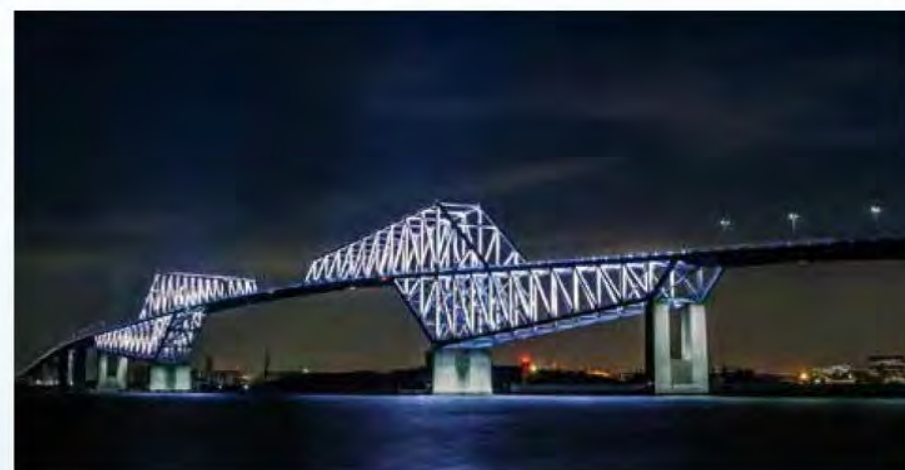
東京ゲートブリッジ照明工事
