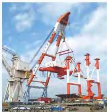
コンテナクレーン設置工事
