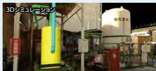
3Dシミュレーションにより、移設後設備の据付場所を検討し配管ルートを確認
