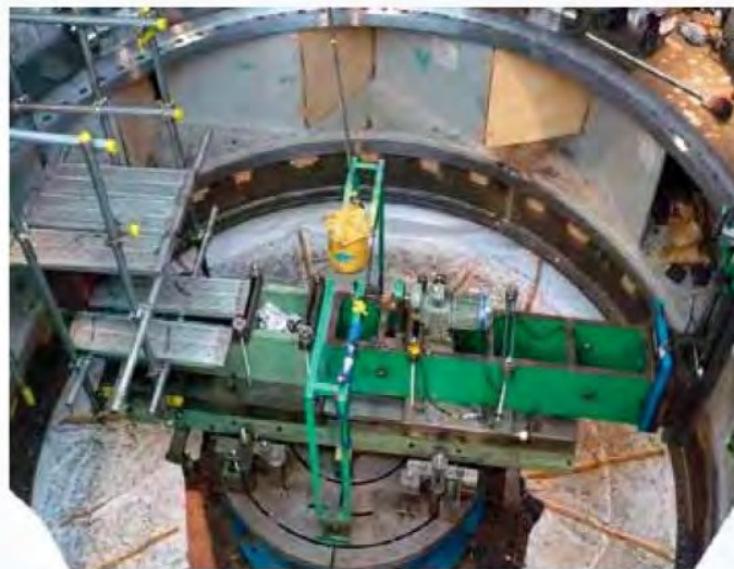
水力発電 据繰り現地加工
