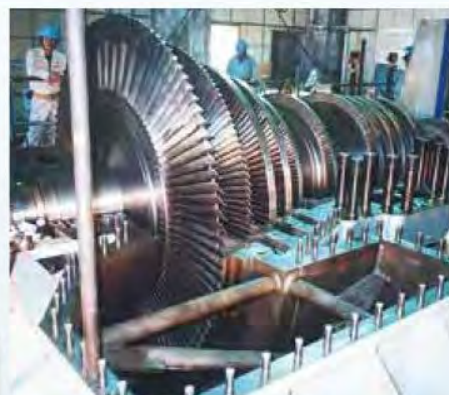
蒸気タービン据付け工事
