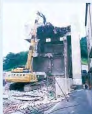
焼却炉解体工事
