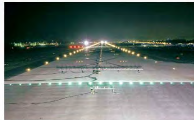
航空灯火設置工事
