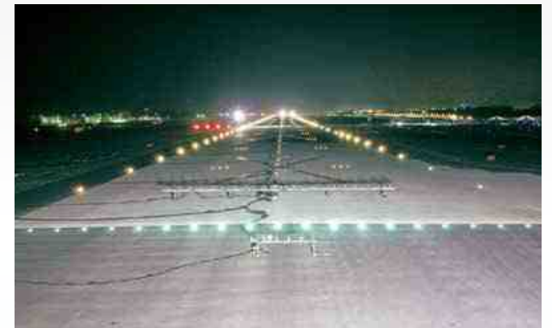
航空灯火設置工事
