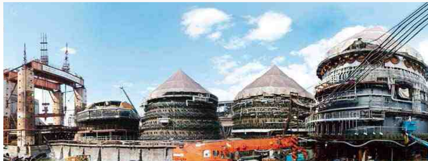
大型高炉大ブロックリング工法改修工事
