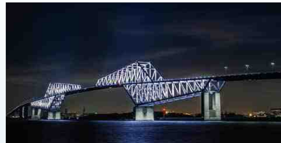
東京ゲートブリッジ照明工事
