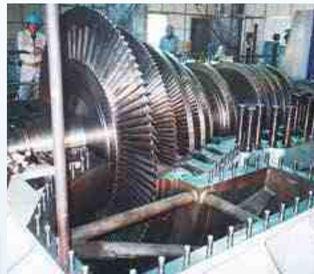
蒸気タービン据付け工事
