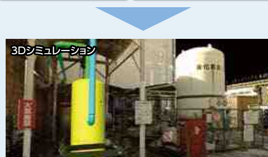
3Dシミュレーションにより、移設後設備の据付場所を検討し配管ルートを確認
