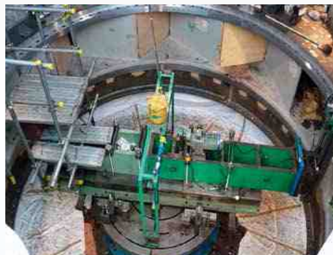
水力発電 据繰り現地加工
