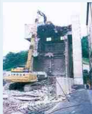
焼却炉解体工事
