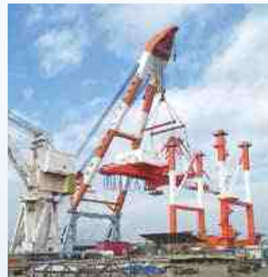
コンテナクレーン設置工事
