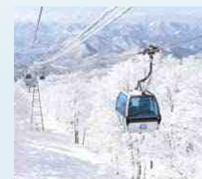
ゴンドラリフト設備
