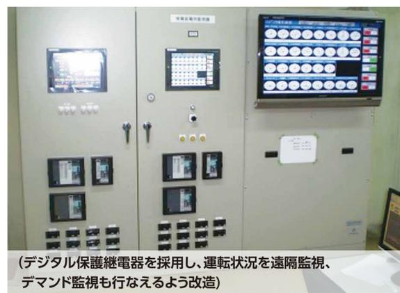
(デジタル保護継電器を採用し、運転状況を遠隔監視、デマンド監視も行なえるよう改造)
