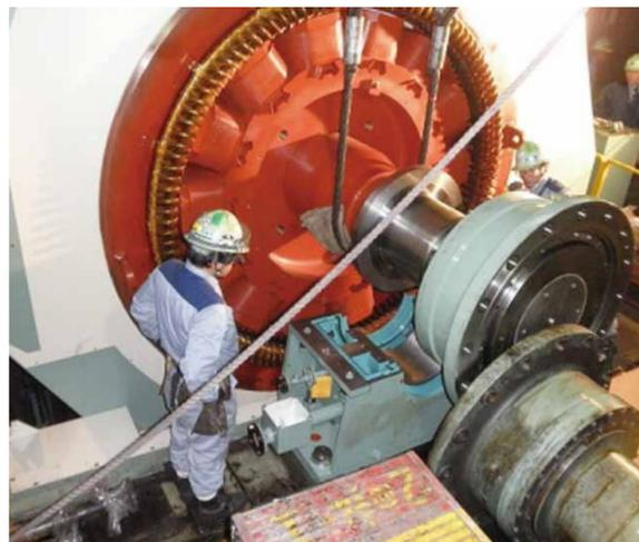
新電動機 回転子挿入
