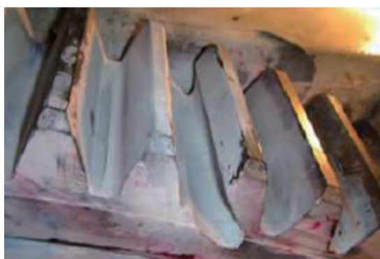
亀裂部削除後
