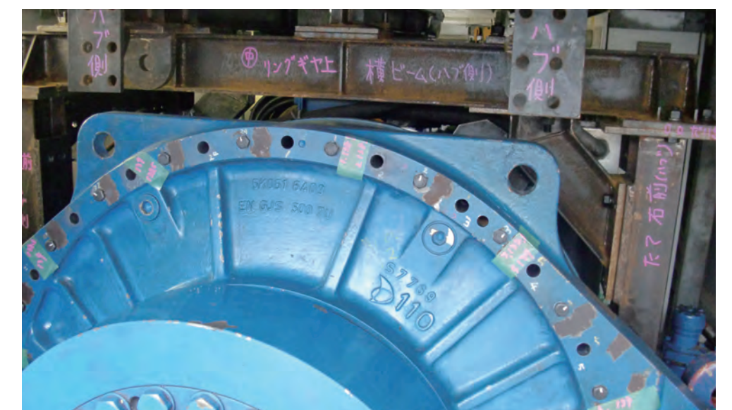
狭隘な機上機内での施工補助架構
