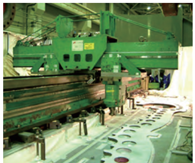
タービンケーシングの現地加工
