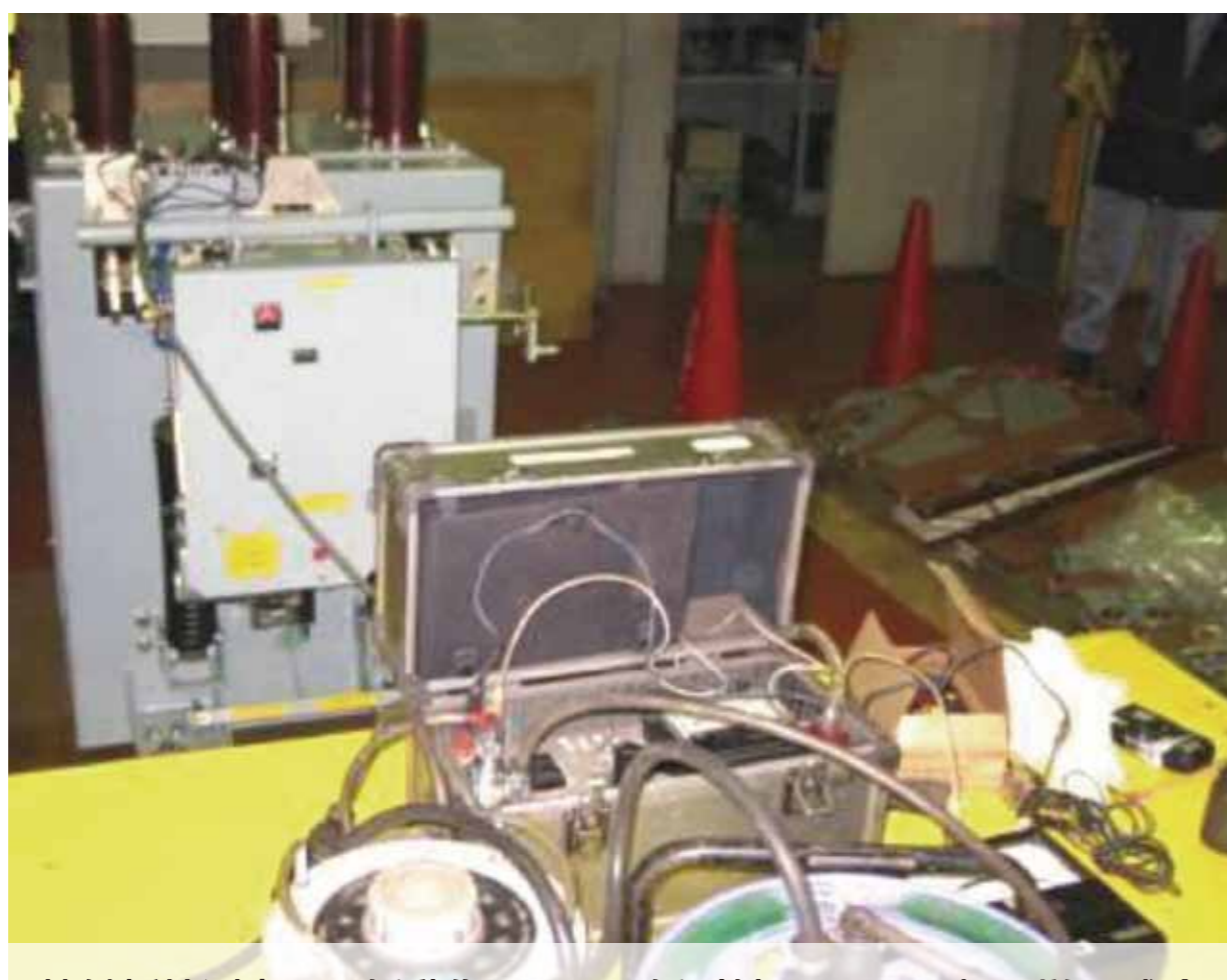
接触抵抗測定 最低動作電圧 最低引外し電圧 3相不揃い試験
