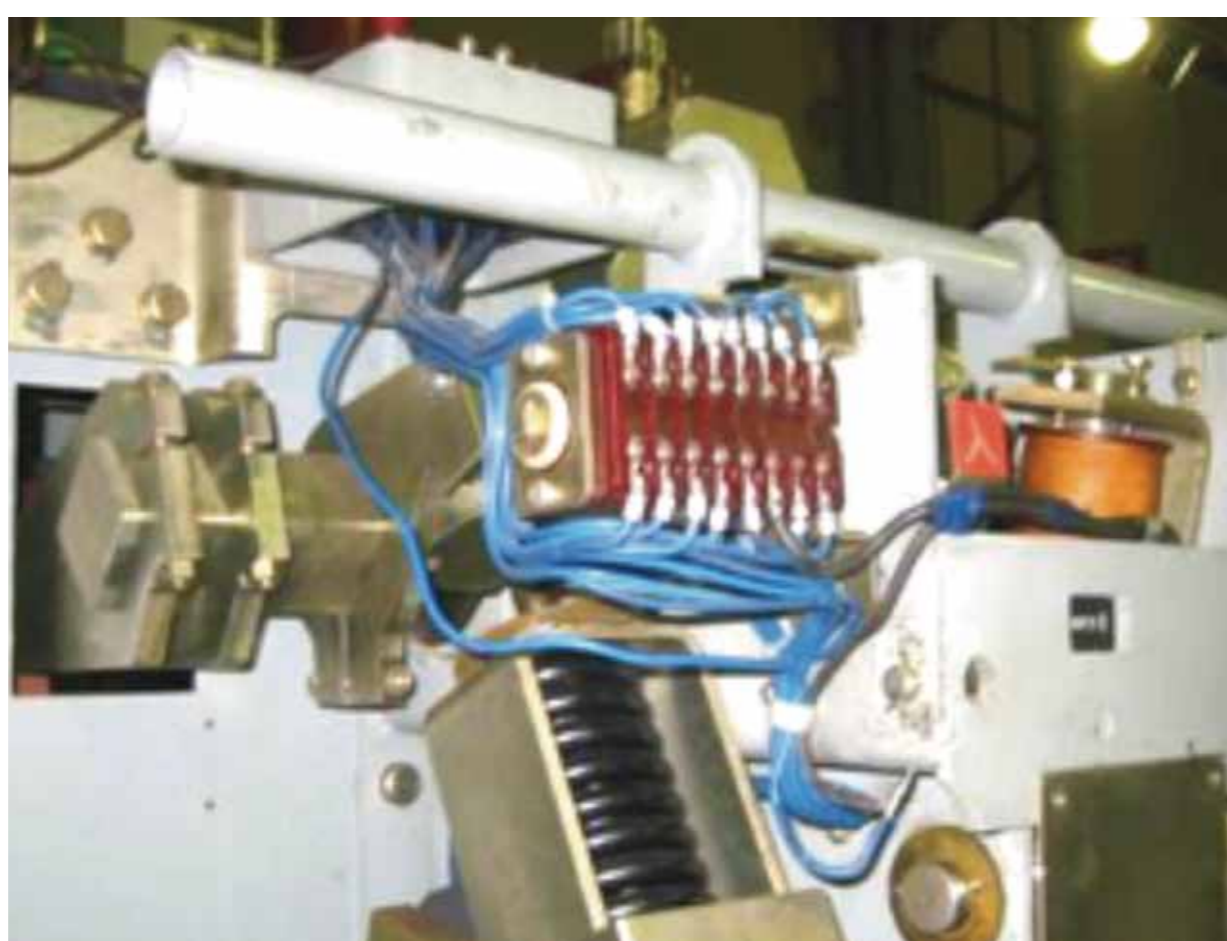
トリップコイルから二次断路端子までテスターにて導通確認
