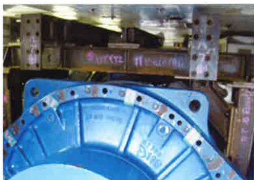
機内増速機本体補修用架構
