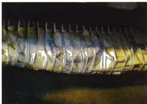
発電機絶縁回復(絶縁テープ巻き直し)
