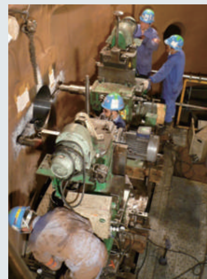
炉体更新工事
