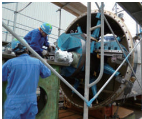
タワーフランジφ3800駐車場での加工
