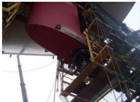
船尾ボーリング加工
