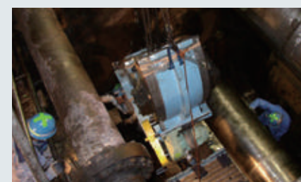
半割れ機械設置
