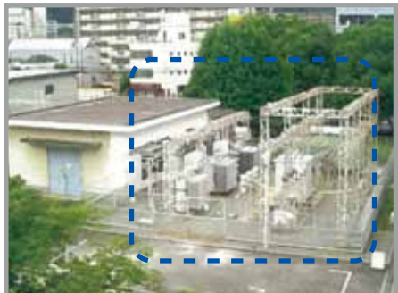
スケルトンタイプ22kV受電設備を配電盤に更新
