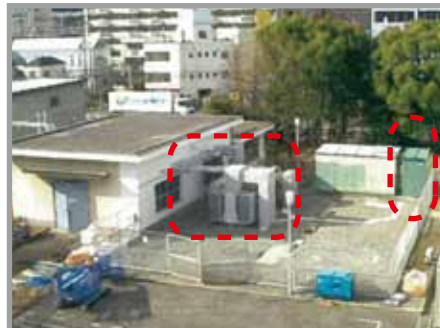
スケルトンタイプ22kV受電設備を配電盤に更新
