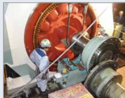
新電動機の据付け
