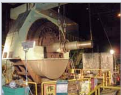
旧電動機の撤去
